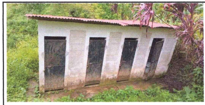
Foto 6: pintura para baños dentro y fuera
